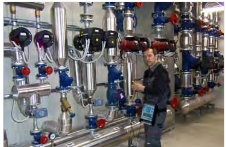
Beim Einregulieren der Anlage mit dem HERZ-Messcomputer Flow Plus.
