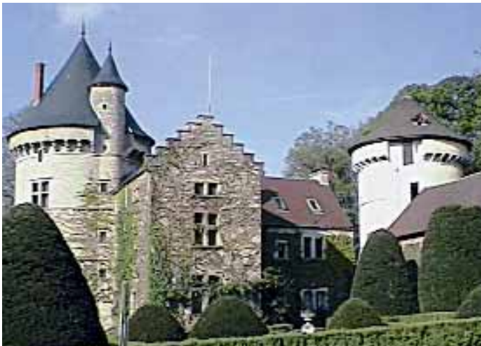
Schloss Dizimieu ist Firmensitz und Referenzprojekt zugleich. Hier wurde 2000 die erste HERZ-firematic Hackschnitzelheizung in Frankreich in Betrieb genommen.
