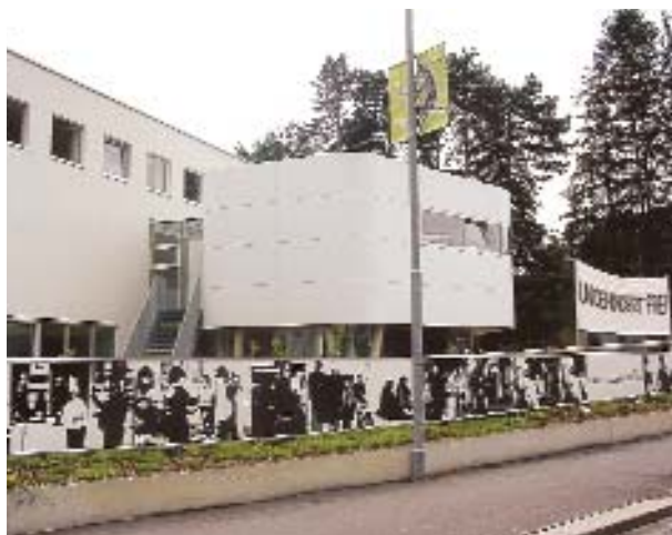
Der Neubau des »Hauses der Begegnung« in Innsbruck wird mit einer umweltfreundlichen HERZ-Biomatic-Anlage beheizt. Ein weiteres altes Gebäude, das ebenfalls von der Diözese genützt wird, wird über eine Fernleitung durch die selbe Anlage mit Wärme versorgt.
