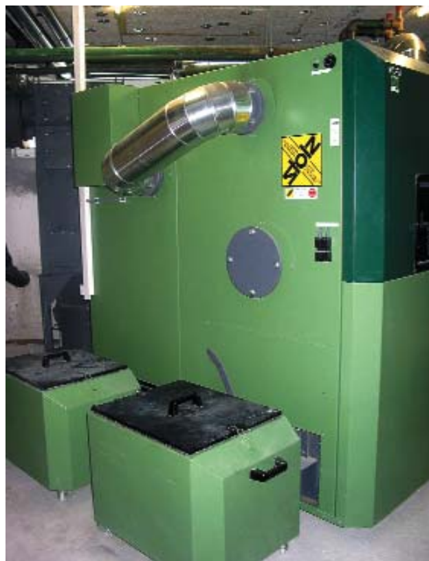
HERZ-Biomatic-Feuerungsanlagen gibt es für das Leistungsspektrum 180 bis 500 kW, sie sind einsetzbar für die Objektwärmeversorgung, die Nahwärmeversorgung in dicht verbauten Orten und für sogenannte Mikronetze.
